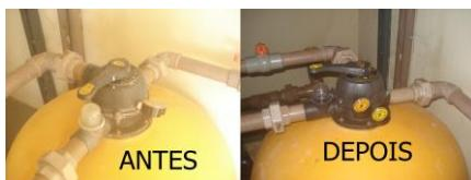
I april ble bassenget tappet ned og det ble gjennomført full utskifting av fliser. Vi har også oppgradert rensefunksjon med bl.a sandfilter, filterhode og kontrollventiler i tillegg til
