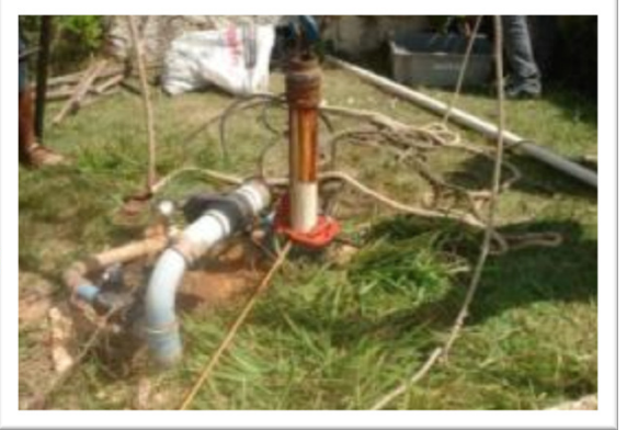
Fjernet og reparert 2 vannpumper og pågående arbeid med å reparere det elektriske .
